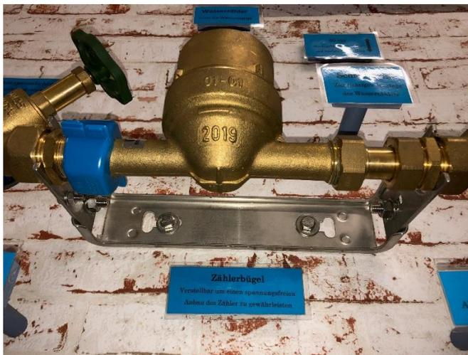
In den meisten Fällen verfügt der Altzähler bereits über den passenden Zählerbügel. In sehr alten Installationen kann es aber vorkommen, dass noch kein Bügel verbaut ist. Dann ist es notwendig, **dass Sie noch vor dem Zählerwechsel Ihren Fachbetrieb (Installateur) mit der Nachrüstung beauftragen**. Bitte prüfen Sie Ihre Anlage daher vorsorglich, ob ein Zählerbügel vorhanden ist.
