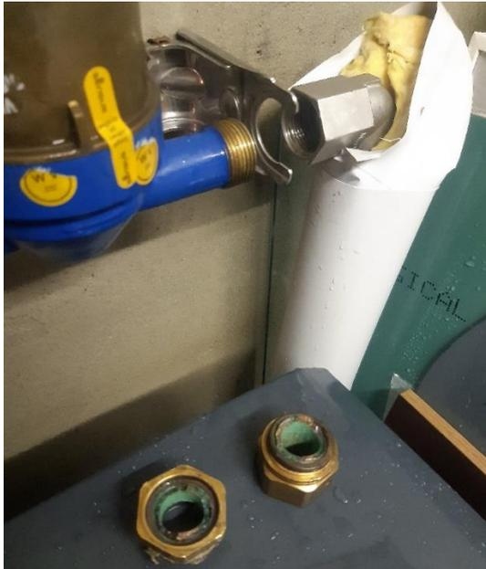
In letzter Zeit kommt es vereinzelt zu Fällen defekter Messingverschraubungen an den Übergängen von Haupt-Wasserzähler.
